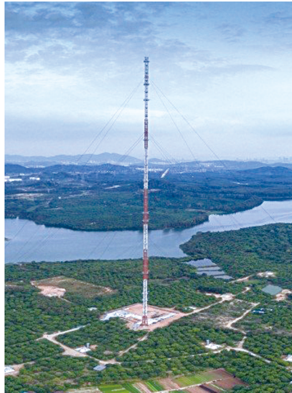
石岩大气成分观测梯度塔 (13层 356米)
